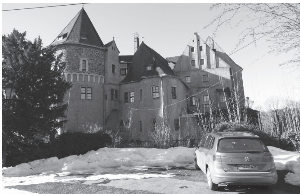
4 | Aktuell erstreckt sich hier eine betonierete Parkplatzfläche. Der Gehölzaufwuchs versperrt zunehmend die Sicht auf das Schloss, Sarah Maibuhr 2017.
