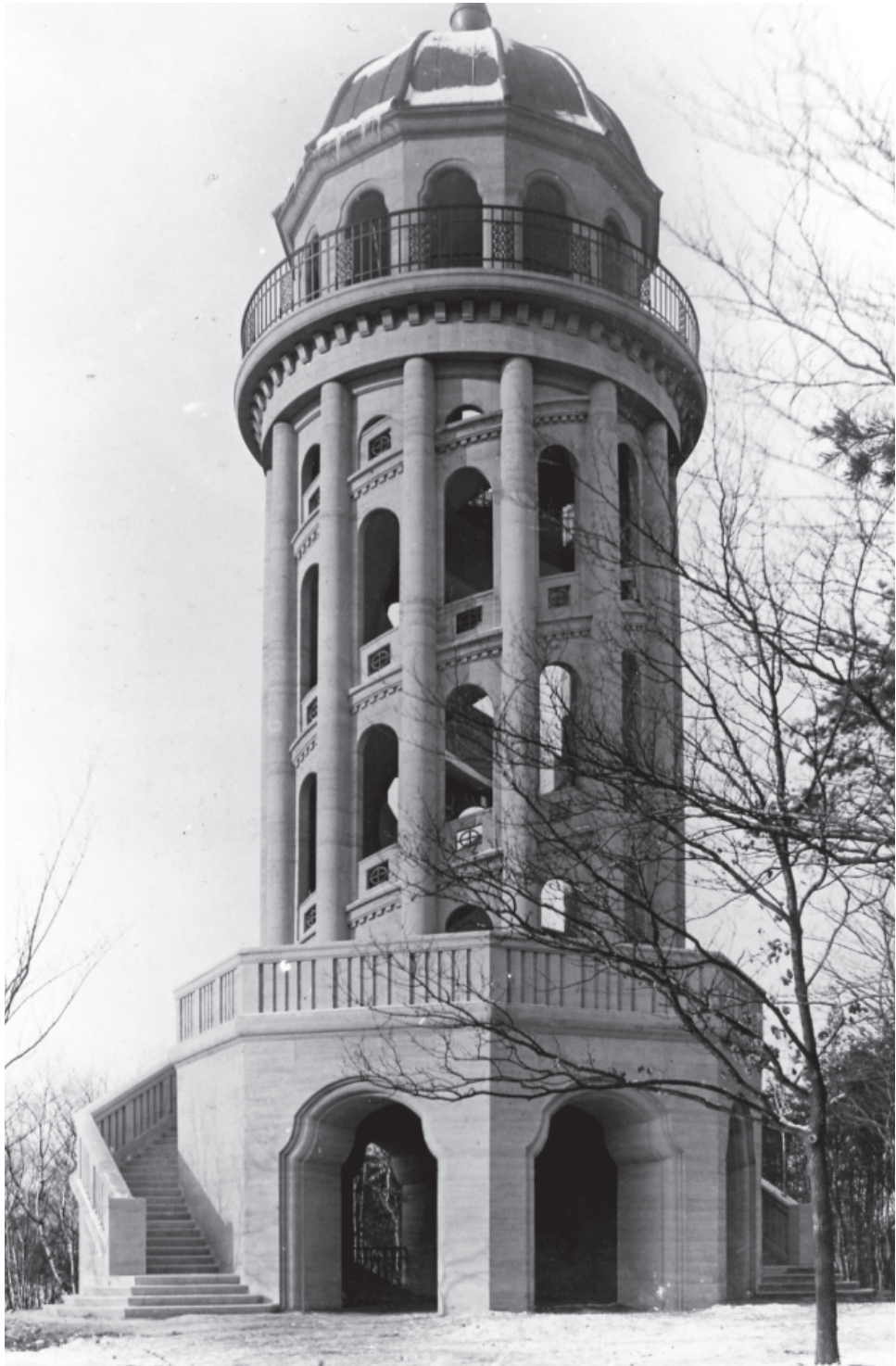
8 | Wolfshügelturm im König-Albert-Park. Ehemals als moderner Stahlbetonbau nach Plänen von Hans Erlwein 1911 erbaut, markierte er den höchsten Punkt des Geländes im Waldpark. Heute zeugen nur noch Trümmer von seiner Existenz (Bildstelle des Stadtplanungsamtes Dresden, Rp 9805 o. J.).
