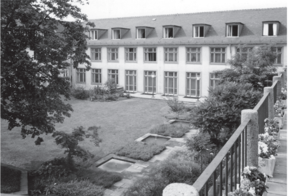
1 | Blick von der Dachterrasse in den westlichen Innenhof der Alten Mensa, 1960er Jahre. Über die quadratischen Wasserbecken an den Sitzplätzen geht der Blick über die leicht ausmodellerte Rasenfläche zu den bodentiefen Fenstern des heutigen Verwaltungstrakts (Diasammlung am Institut für Landschaftsarchitektur der TU Dresden).
