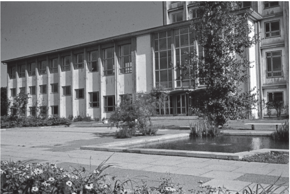
2 | Der Vorplatz des Andreas-Schubert-Baus zeigte neben einem Wasserbecken und einer leuchtenden Bepflanzung mit Rudbeckien, die typische Verwendung großformatiger Betonplatten mit unterschiedlicher Farbigkeit, wodurch die Fläche eine grafische Wirkung erhielt, 1960er Jahre (Diasammlung am Institut für Landschaftsarchitektur der TU Dresden).
