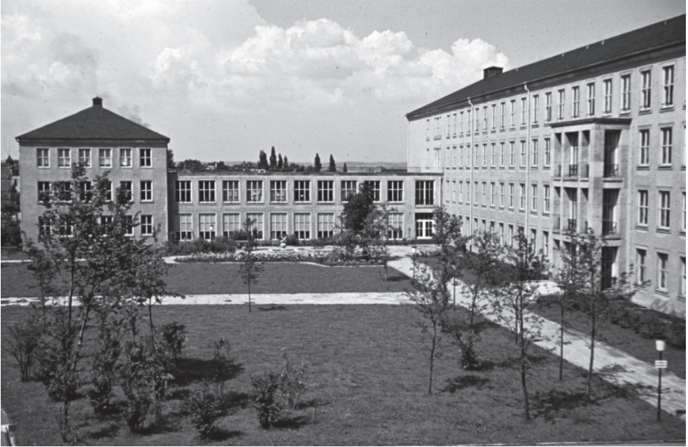
3 | Das historische Foto des Potthoffbaus zeigt deutlich die Zonierung der Grünflächen mit stark ausgestalteten und mit Stauden, Rosen und Ziersträuchern akzentuierten Aufenthaltsbereichen sowie den eher unter praktischen Gesichtspunkten mit relativ einfachen Mitteln gestalteten Umgebungsbereichen des Institutsgebäudes, 1960er Jahre (Diasammlung am Institut für Landschaftsarchitektur der TU Dresden).
