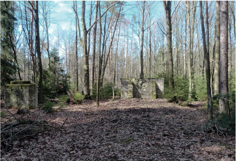
17 | Die gemauerte Zielscheibe samt Kugelfang am Schießhaus zu Reinhardtsgrimma, Fotografie: Anja Gottschalk, März 2019. Mittig ist die gemauerte Zielscheibe zu sehen und am linken Rand der zur Schießscheibe halb geöffnete Kugelfang.
