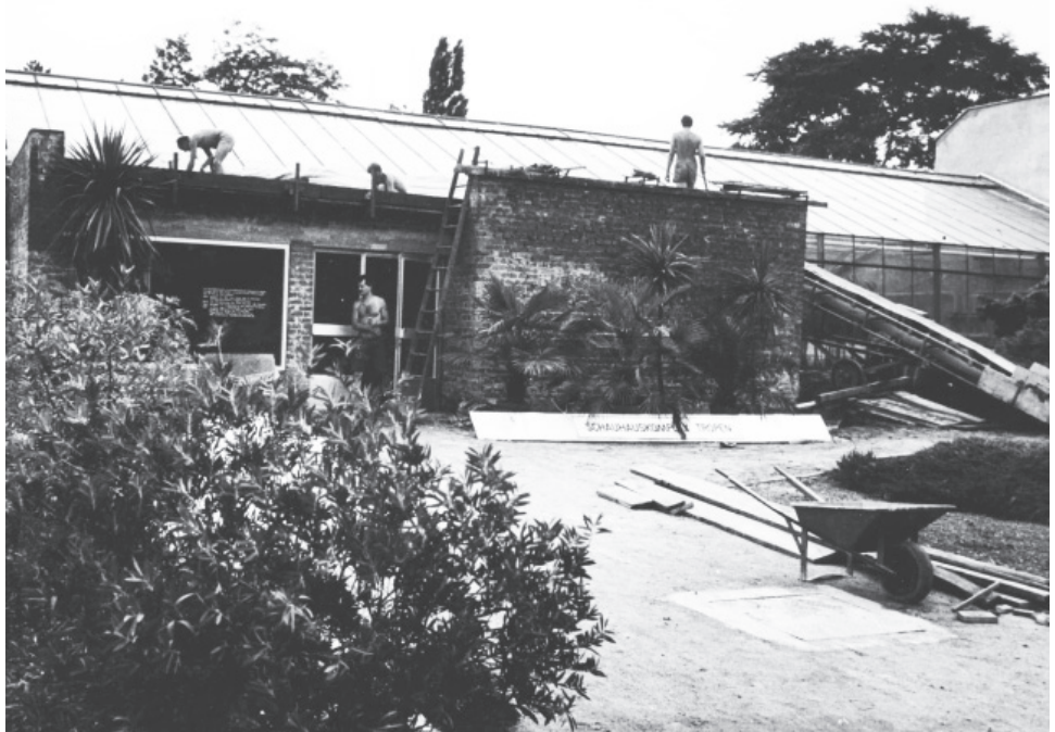
5 | Baustelle des Tropenhauses, 1981 (TU Dresden, Botanischer Garten, Fotoarchiv).
