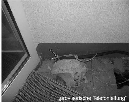
Der heizungslose Winter inspirierte die Institutsmitarbeiter dennoch zu Höchstleistungen. Doch auch weitere Widrigkeiten gab es: Bei der Demontage der Heizungsanlage wurde mehrfach die Telefonleitung des MRI gekappt und teilweise komplett demontiert, was nur dank gehörigem Improvisationstalent und effektivem Krisenmanagement kaum Auswirkungen auf den Institutsalltag hatte.
