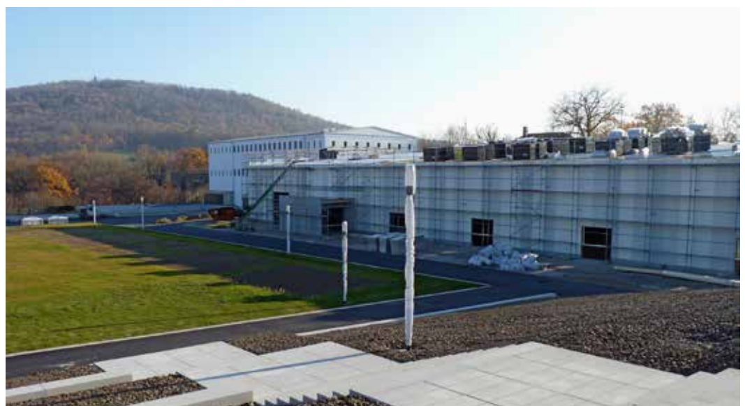
Bau der Messe- und Veranstaltungshalle
