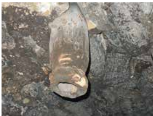
Keller Leipziger Straße 34, Bierablassröhre im Gewölbescheitel der Kellertonne, Foto: Jürgen Herzog
