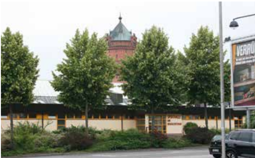
unten: Torgau, Wohngebiet Husarenpark an der Dommitzcher Straße © Stadtverwaltung Torgau
