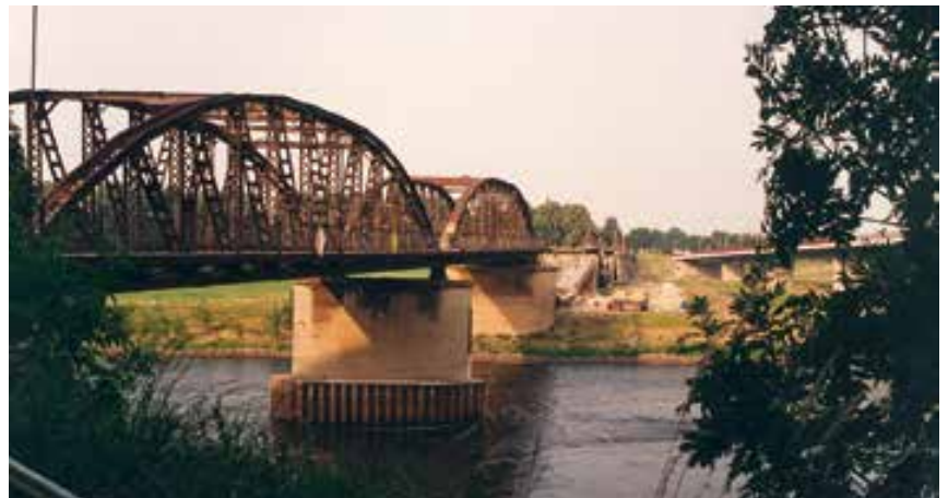
Alte Elbbrücke, rechts Bau der neuen Elbbrücke, 1992 © Stadtverwaltung Torgau
