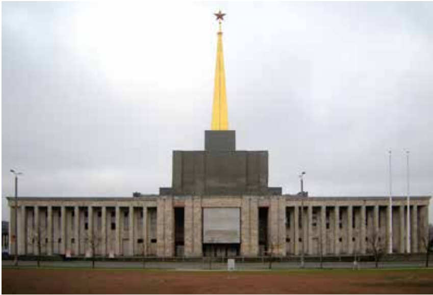
Sowjetischer Pavillon, Zustand nach 2004
