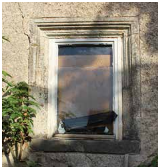
links: Herrenhaus Lötzschen, Fenstergewände mit feiner Profilierung
