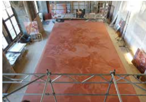
Die Leinwand wurde auf einem Malgerüst am Boden bemalt. Nach Abschluss der Untermauerung wurde das Gemälde gedreht und zum Einpassen in die Decke vorbereitet. Zustand im September 2018.
