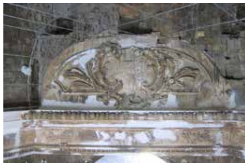
Zwischenzustand zu Beginn der Stucksanierung, Juli 2017
