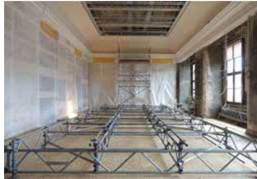
Residenzschloss Dresden, Audienzgemach, Zustand im Juli 2018. Der Spannrahmen für das Leinwandgemälde hängt eingepasst in der geputzten Deckenfläche.
