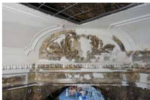
Zwischenzustand während der Ergänzung der Deckenkubatur, September 2017
