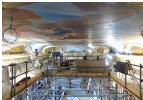
Die weitere Bemalung der Leinwand und der umgebenden Putzfläche erfolgte von einem Raumgerüst, dessen Mittelteil verschiebbar war und eine ständige Kontrolle der Arbeiten ermöglichte. Zustand im April 2019.
