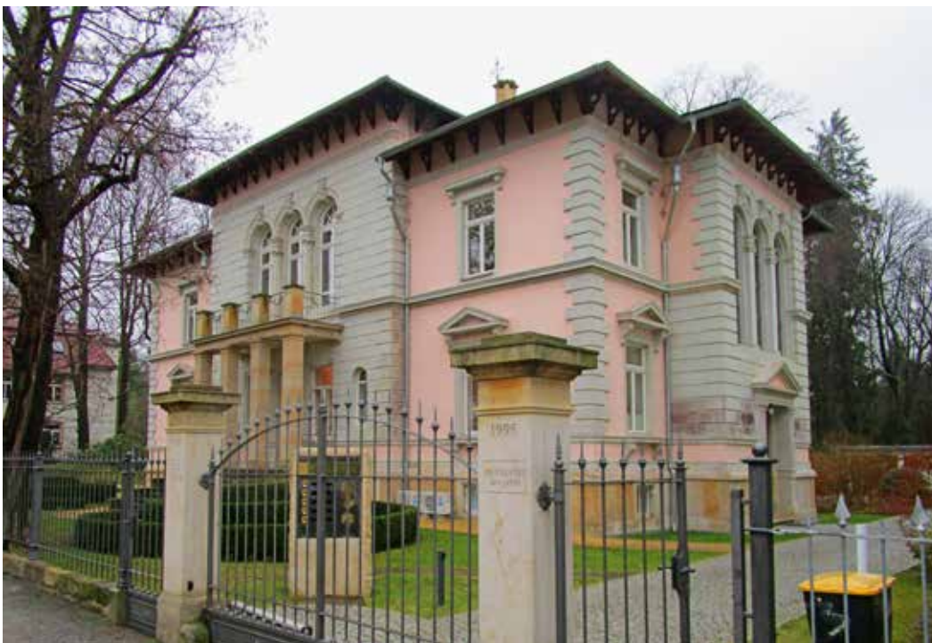
Das „Museum Ludwig Salvator“ in Dresden-Blasewitz nach seiner Renovierung, Fotografie, 2017 Foto: Thorsten Heese, Osnabrück
