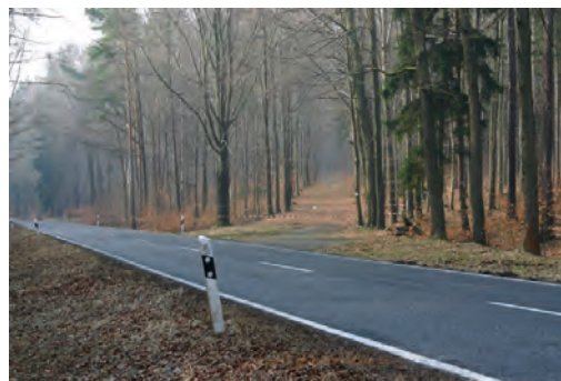
Südlich Eichgraben verlässt die moderne Straße – seit 1848 – die Trasse der Alten Gabler Straße, um das folgende Steilstück mit einer großen Kehre zu umgehen. Beiderseits der gepflasterten alten Straße dokumentieren zahlreiche Hohlen einen noch älteren Straßenhorizont. Foto: Gunter Oettel
