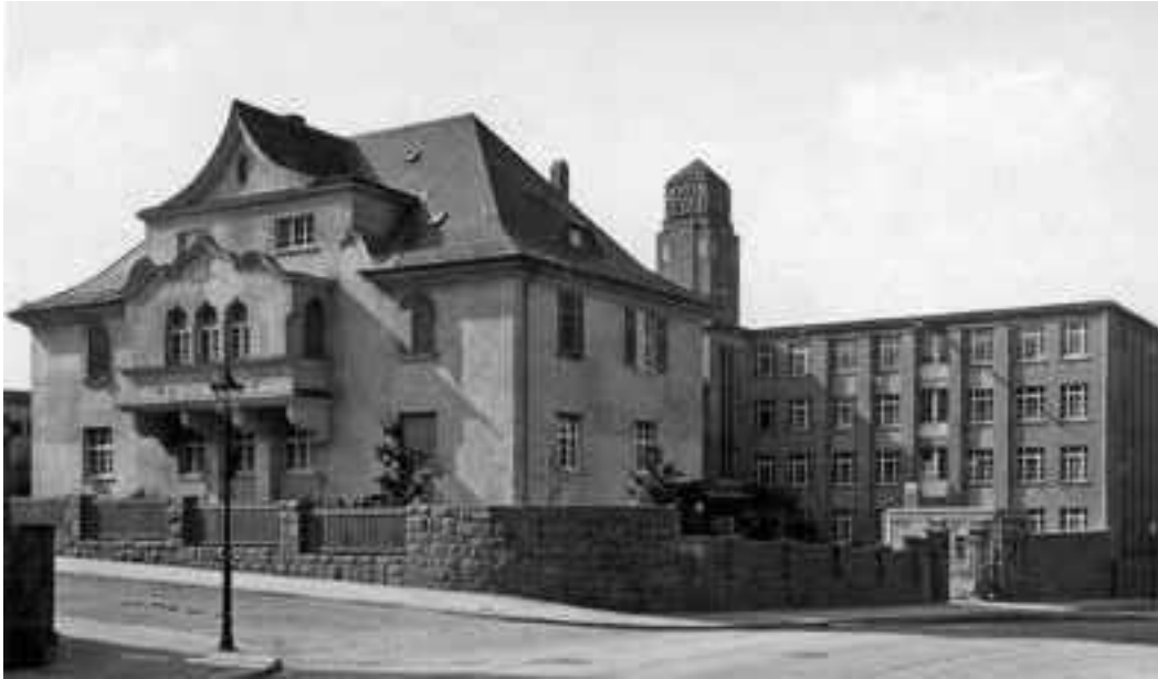
Limbach-Oberfrohna, Hohensteiner Straße 2, Wohnhaus und Fabrikgebäude der Wirkwarenfabrik Paul Uebel, gegründet 1888 © Sammlung Daniel Polster
