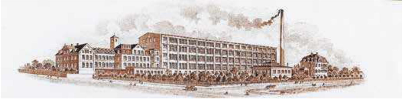
Ansicht der Wirkerei Welker & Söhne, um 1900
