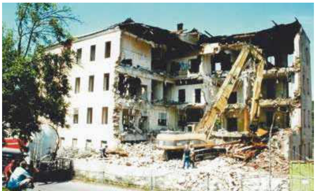
Abbruch der Industriebrache des VEB Malitex, 2008
