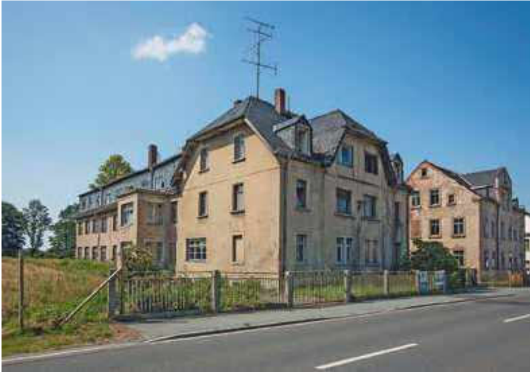
Limbach-Oberfrohna, Hohensteiner Straße 110/112, Ruine der ehemaligen Wirkwaren- und Handschuhfabrik Gotthardt A. Sallman, Abriss für altersgerechten Wohnpark in Planung, 2015 Foto: Andreas Grünewald
