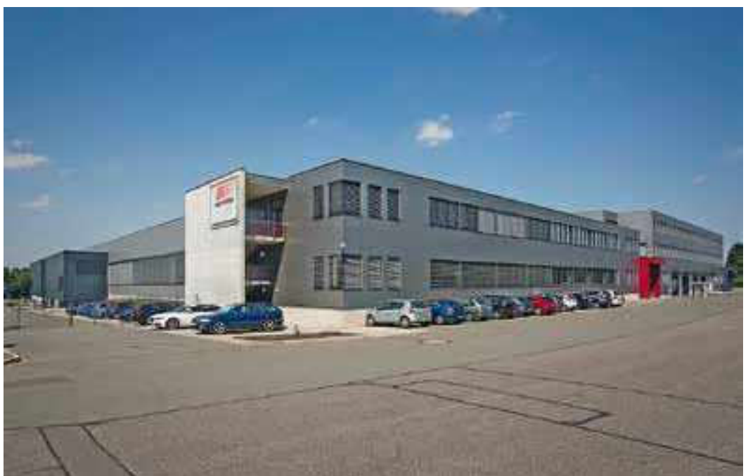
Limbach-Oberfrohna, Ostring 6, Fabrik- und Verwaltungs- gebäude der WAREMA Sonnenschutztechnik GmbH, zuletzt erweitert 2011, 2015 Foto: Andreas Grünewald
