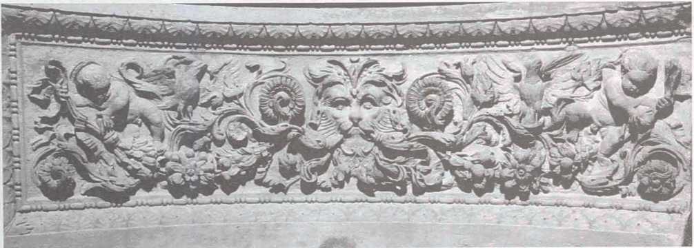
Abb. 13: Dresden, Residenzschloß, Schloßkapellenportal, Rankenfries des Torbogens, linker Teil innen, 1555, nach der Reinigung mit Laser, 2005
